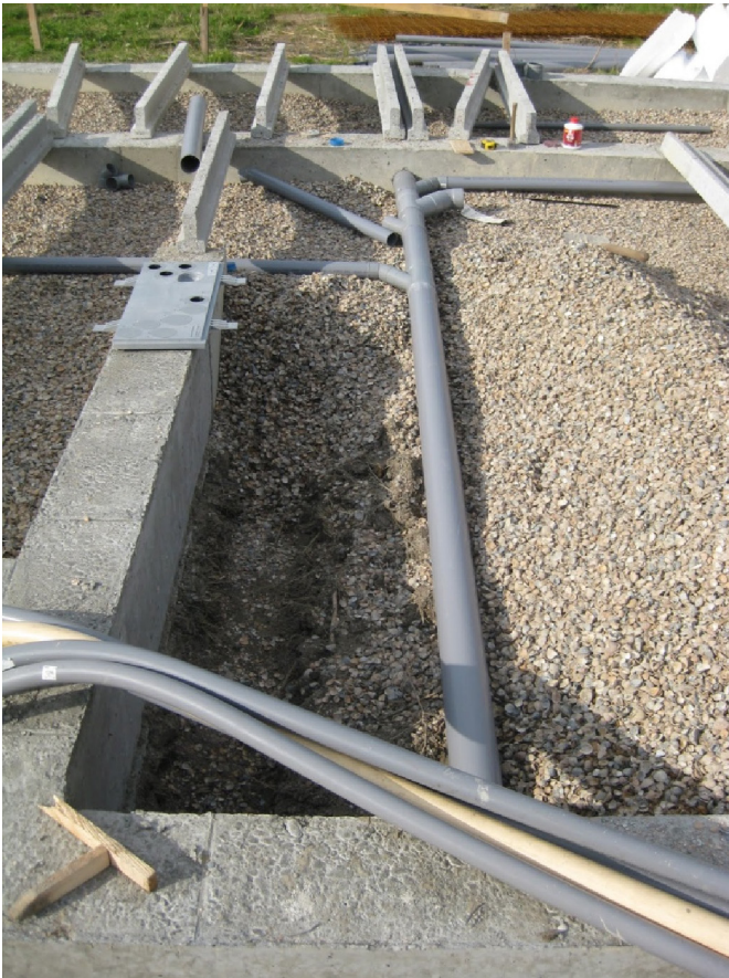
Afbeelding 6.4: kruipruimteloos bouwen gevuld met schelp als lichtgewicht materiaal en isolatie. Het riool moet nog wel bevestigd worden aan de vloer.
