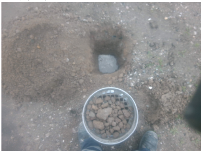
Fotonummer: 9 Omschrijving: Boring 206 puin en grondwater in gat
