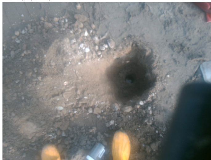
Fotonummer: 34 Omschrijving: Boring 222
