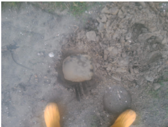
Fotonummer: 27 Omschrijving: Boring 218
