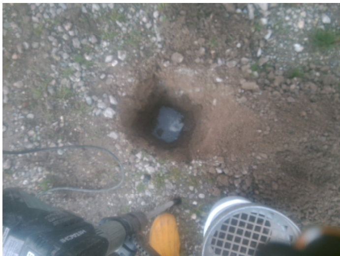
Fotonummer: 23 Omschrijving: boring 215
