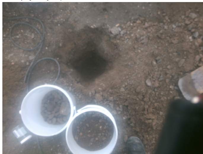
Fotonummer: 10 Omschrijving: Boring 208
