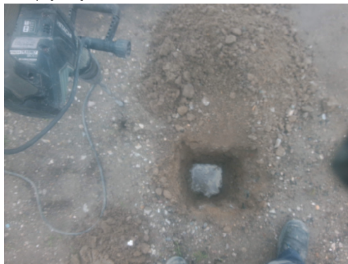
Fotonummer: 6 Omschrijving: Boring 205
