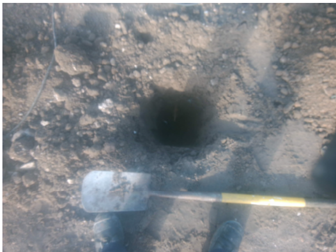
Fotonummer: 3 Omschrijving: Boring 202
