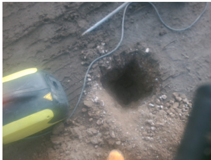
Fotonummer: 32 Omschrijving: Boring 221
