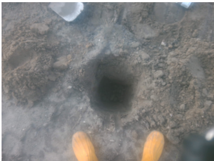
Fotonummer: 1 Omschrijving: Boring 07
