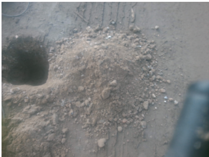
Fotonummer: 31 Omschrijving: Boring 221
