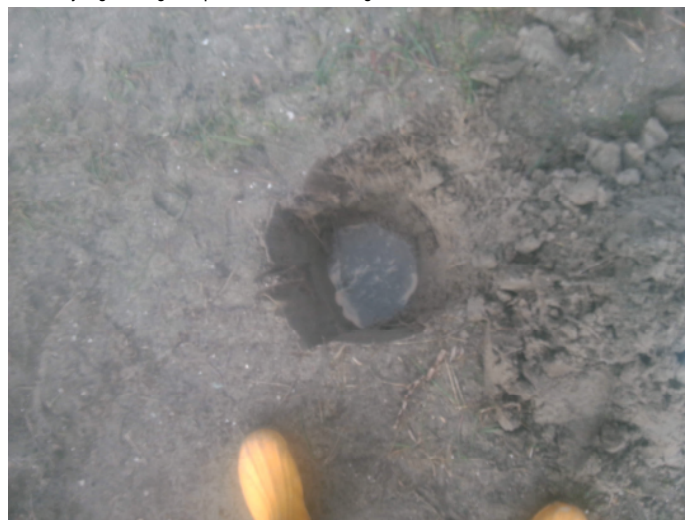
Fotonummer: 26 Omschrijving: Boring 217
