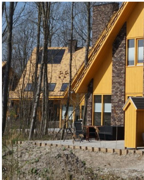
principe van verlaagd maaiveld achter het terras (Boomrijk) - de perceelgrens wordt gemarkeerd door een kantplank. De kantplank wordt bij de aanleg openbare ruimte, aan de boszijde tot vlak onder de bovenkant aangevuld met grond.
