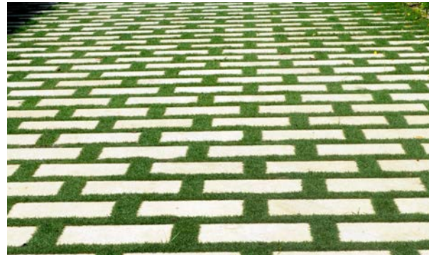
boven voorbeeld insectenblok in de gevel, onder halfopen verharding bieden ruimte voor grond-broedende bijen
