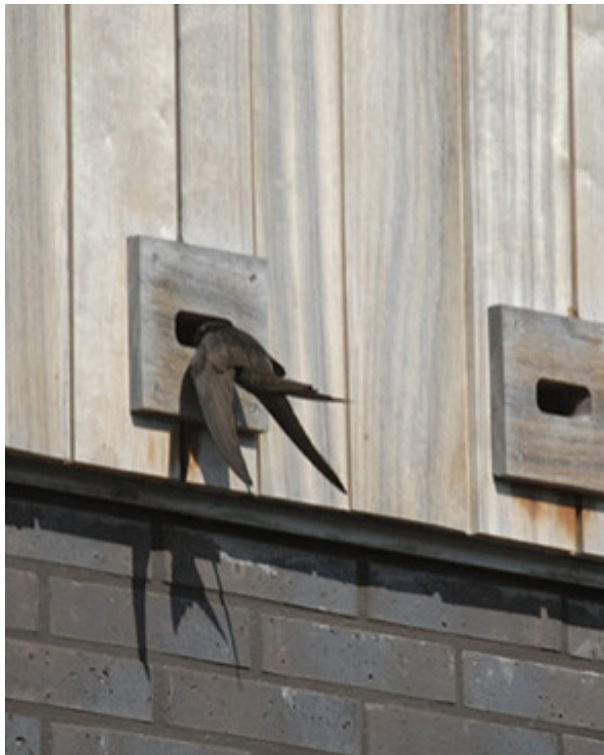
voorbeeld nestkast geïntegreerd in de gevel: elke vogelsoort heeft zijn eigen wensen qua maatvoering
