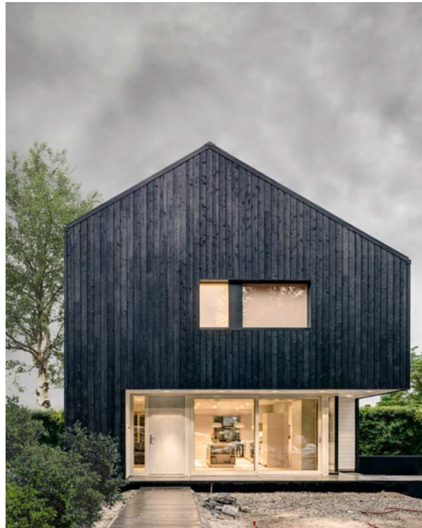
voorbeeld terras als veranda uitgehold in het volume van de woning met de gevel als privacy-schermen
