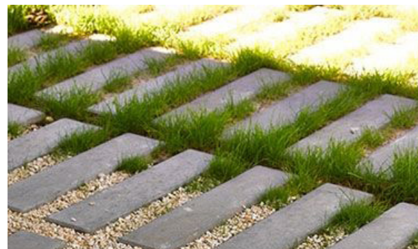
voorbeeld opengewerkt bestratingsverband met grasstenen en daarmee ruimte voor een natuurlijke / groene uitstraling
