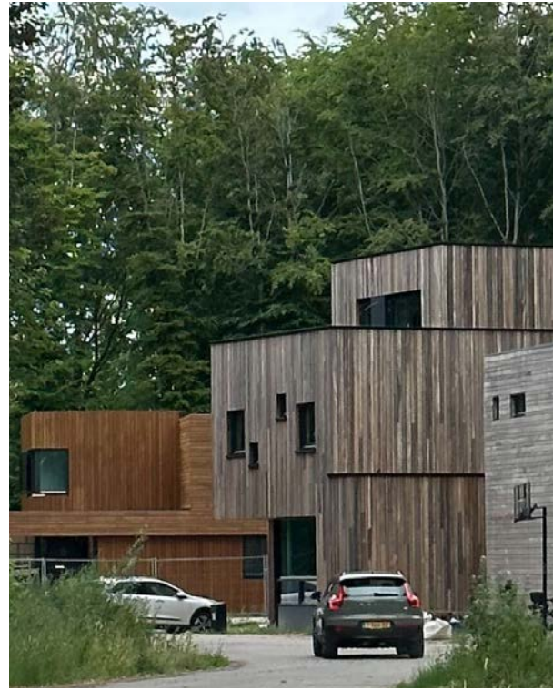
ter inspiratie: gevelbekleding in de Kreekbos Zuid met verschillende houtsoorten passend binnen het gegeven kleurenpalet
