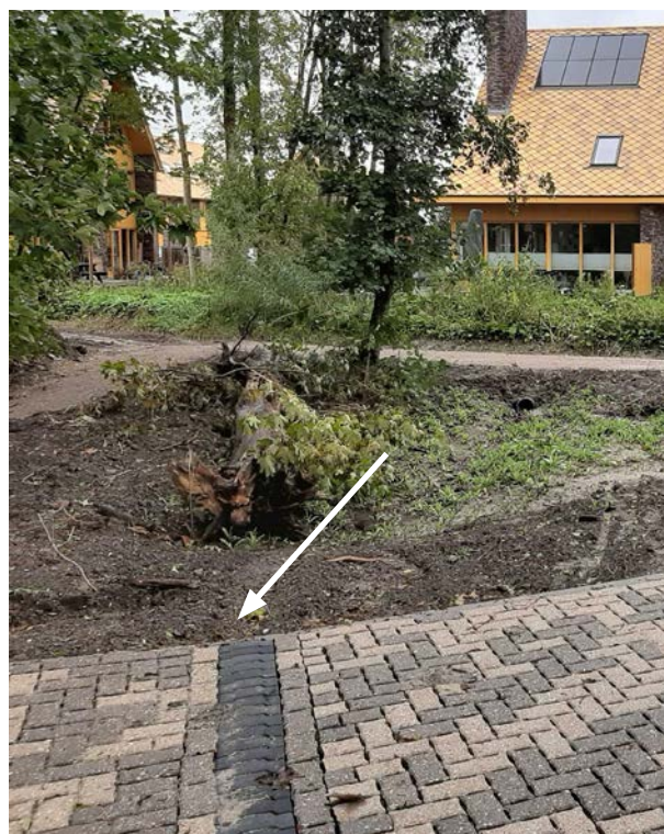
afvoer via goten in openbaar gebied naar lager gelegen maaiveld (bos)
