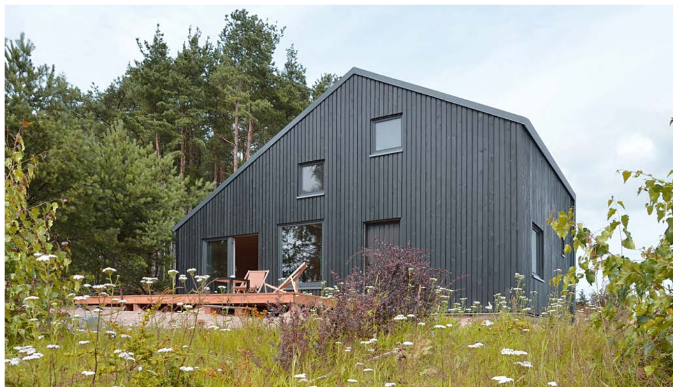
voorbeeld compact volume als één vorm met materiaal- en kleurgebruik dit benadrukt
