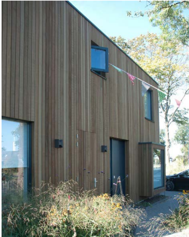
voorbeeld verduurzaamd hout (geen composiet) dat als natuurlijk materiaal qua kleur en textuur vanzelfsprekend aansluit bij de bosomgeving
