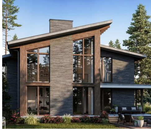
Dakvorm niet symmetrisch en accent door risaliet.
