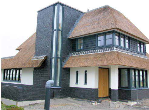
Bijzondere kapvorm door opgetild dak.
