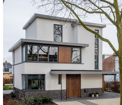
Plat dak met variërende hoogtes.
