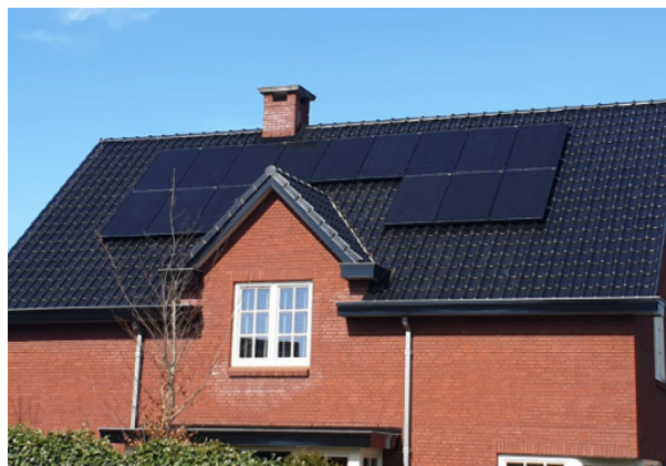
Zonnepanelen mee ontworpen met dak.
