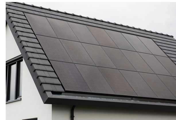
Zonnepanelen mee ontworpen met dak.
