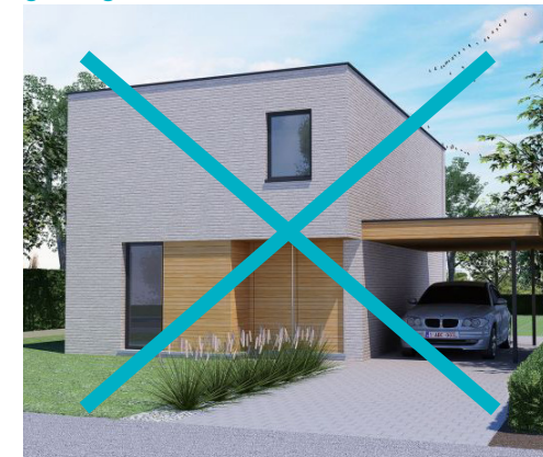
Gevel met te weinig gevelopeningen.
